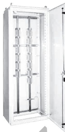
Шкаф промежуточных реле для формирования дискретных сигналов в ПТК
